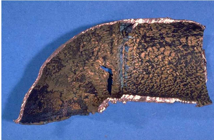
Slika 2.11. Primjer erozijske korozije na unutrašnjosti bakrene cijevi
