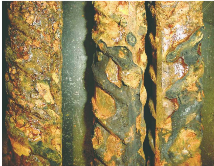
Slika 2.10. Primjer interkristalne korozije na granicama zrna metala
