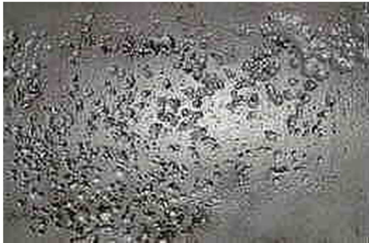
Slika 2.8. Primjer jamičaste korozije na cjevovodnom materijalu
