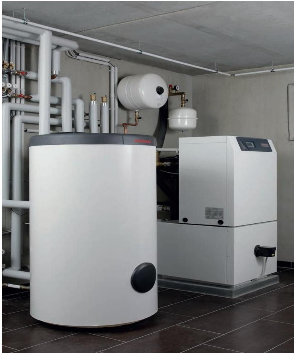
Slika 1. Prikaz geotermalne dizalice topline [3].
