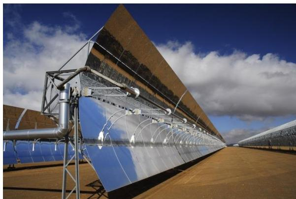
Slika 10. Tipični linearни parabolički kolektor [9]
