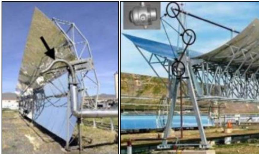
Slika 11. Prikaz fleksibilne cijevi i kuglastog zgloba [10]
