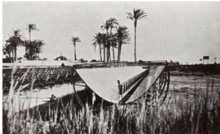
Slika 8. Shumanov solarni parabolički kolektor [7]
