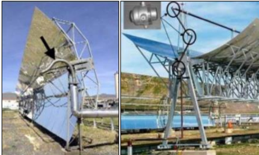
Slika 11. Prikaz fleksibilne cijevi i kuglastog zgloba [10]
