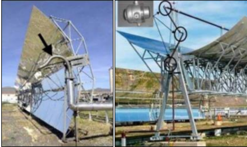
Slika 11. Prikaz fleksibilne cijevi i kuglastog zgloba [10]
