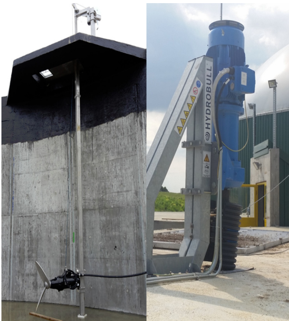
Slika 13 Propelersko miješalo i elektromotor za pogon istog [41]
