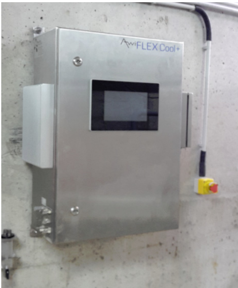
Slika 15 Uređaj za analizu sastava bioplina [41]
