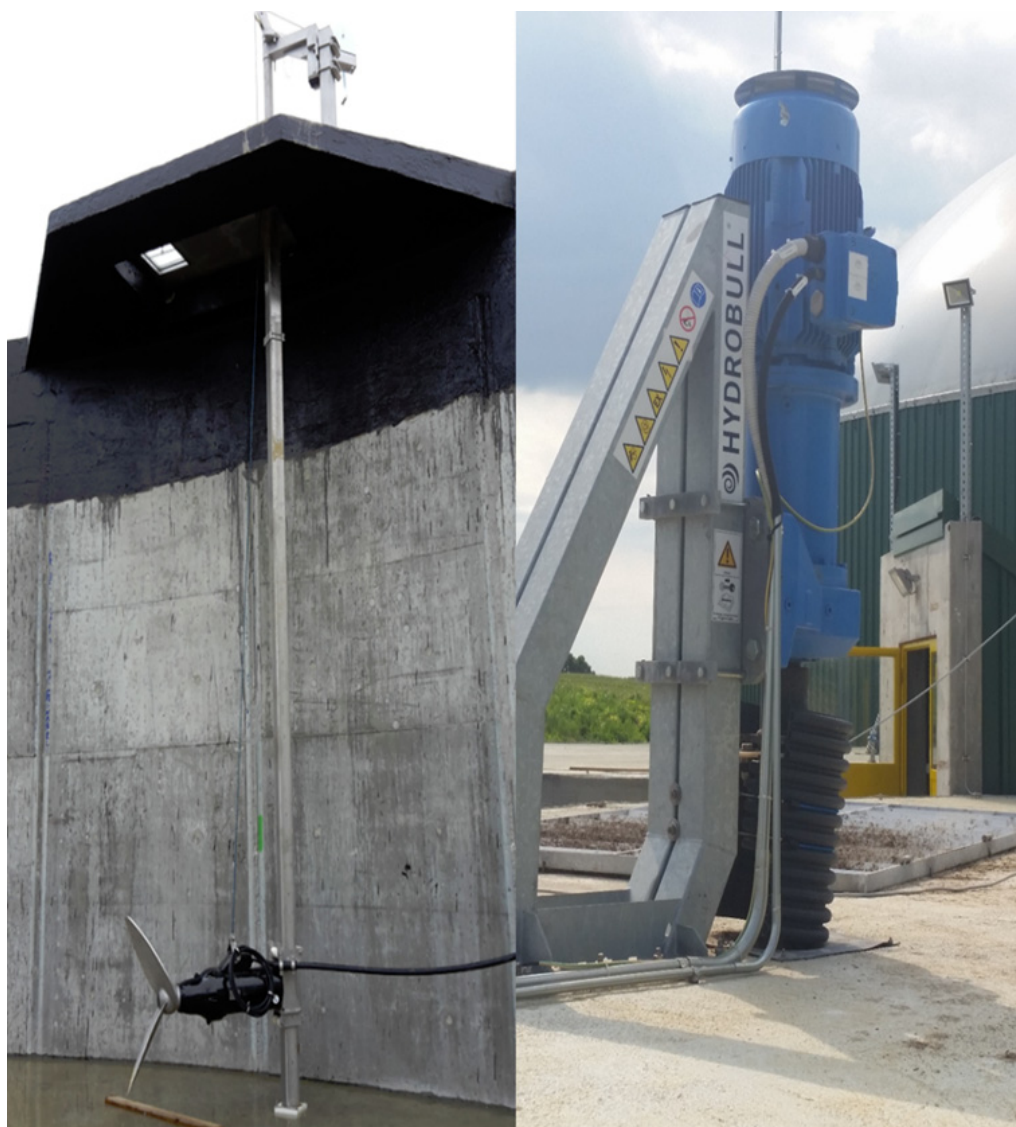
Slika 13 Propelersko miješalo i elektromotor za pogon istog [41]
