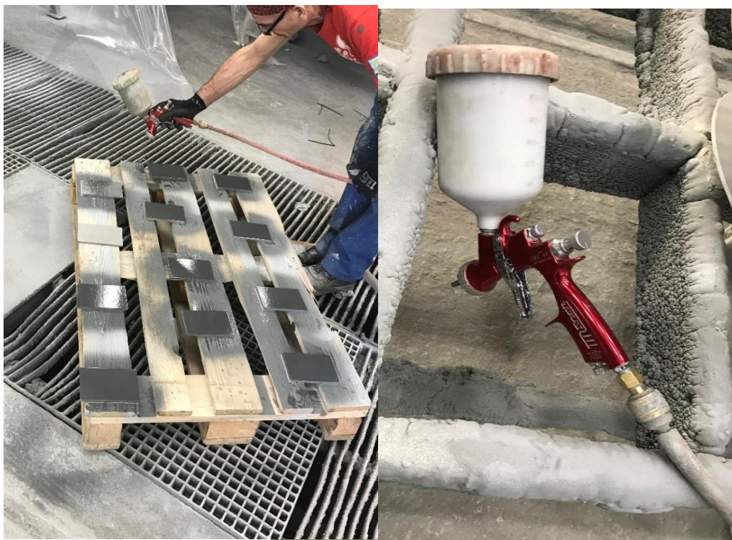
Slika 25. Nanošenje premaza zračnim pištoljem u tvrtki Končar – Metalne konstrukcije
