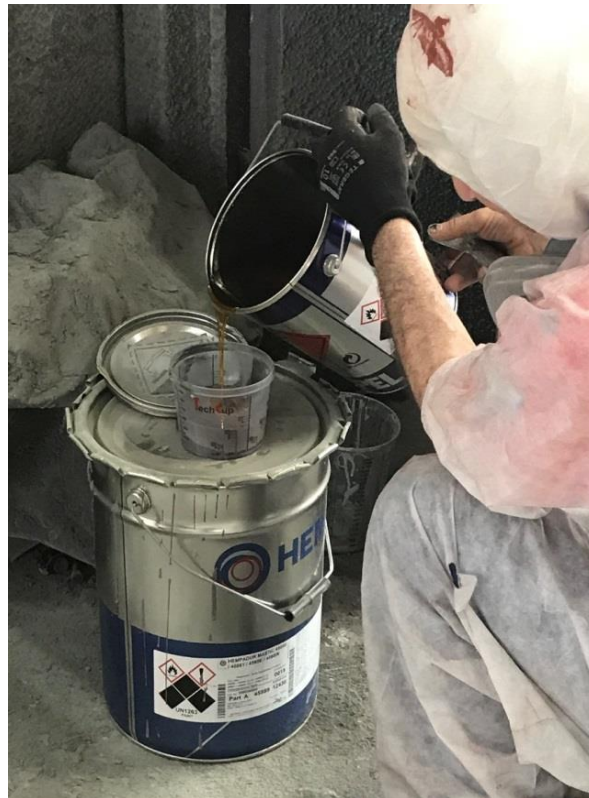
Slika 24. Priprema dvokomponentnog premaza
