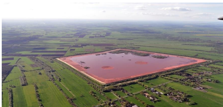
Slika 11. Bazen za odlaganje crvenog mulja u Njemačkoj [78]
