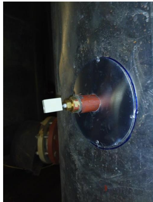
Slika 2-3: Titanska žica kao pseudoreferentna elektroda unutar bojlera (lijevo) te izvana (desno) u sustavu unutarnje katodne zaštite
