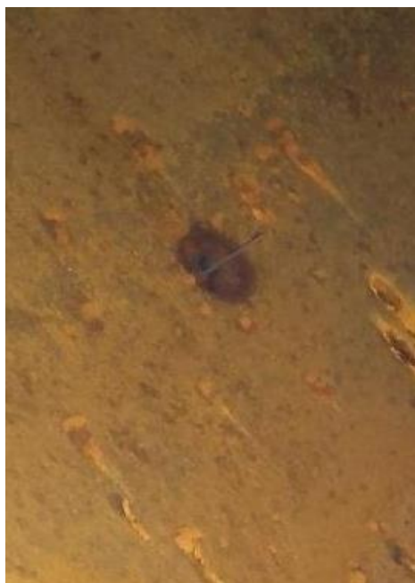
Slika 2-3: Titanska žica kao pseudoreferentna elektroda unutar bojlera (lijevo) te izvana (desno) u sustavu unutarnje katodne zaštite
