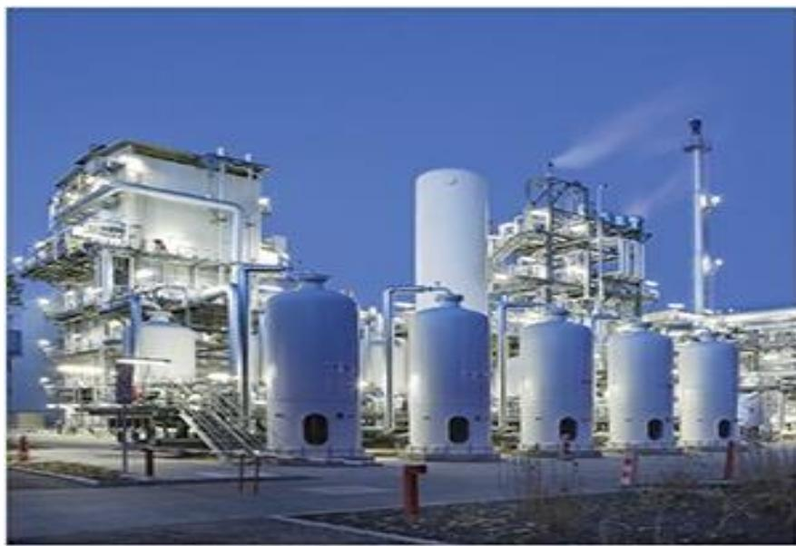
**Slika 10. PSA postrojenje sa pet adsorbera<sup>7</sup>**
