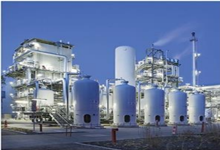
Slika 10. PSA postrojenje sa pet adsorbera 7
