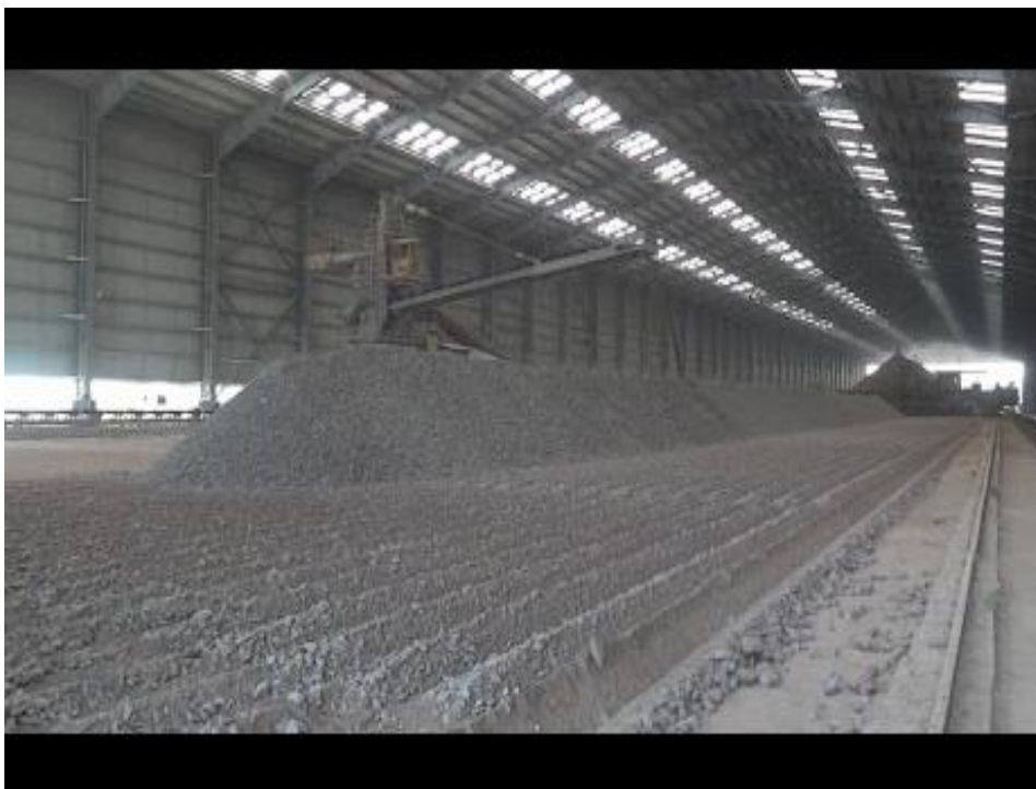
Slika 9. Depo hala u tvornici Našicecement d.d.
