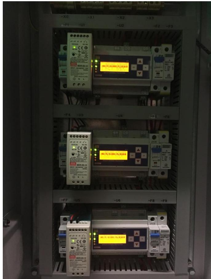
Slika 3-6: Tri kontrolne napojne jedinice
