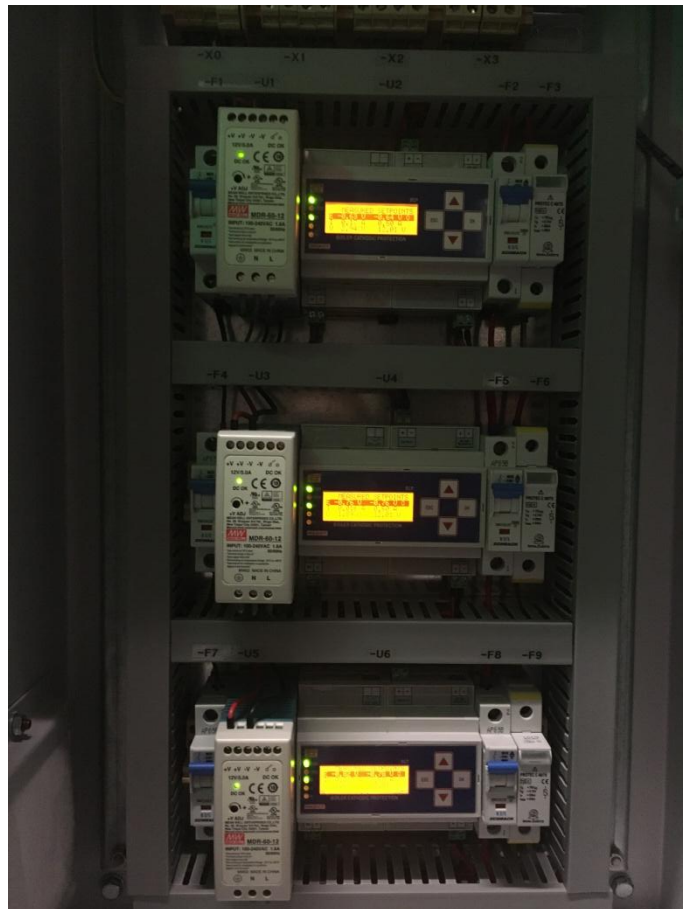
Slika 3-6: Tri kontrolne napojne jedinice
