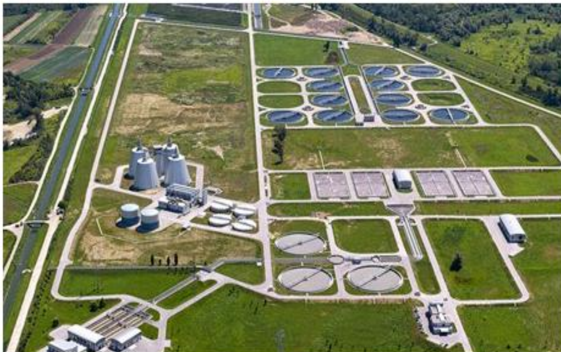
Slika 2. Zagrebačke otpadne vode – Centralni uređaj za pročišćavanje otpadnih voda Zagreba i pripadajuća infrastruktura
