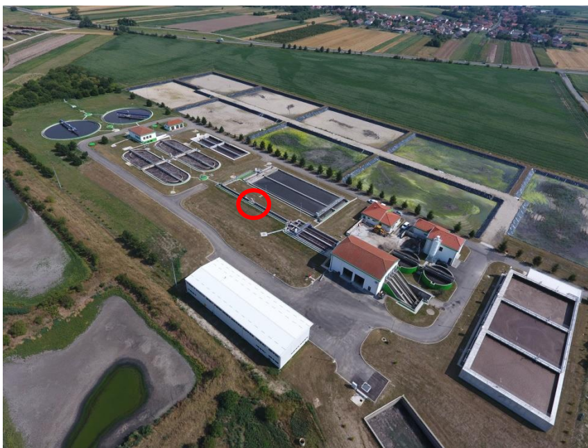
Slika 3.1. Pročistač otpadnih voda aglomeracije Čakovec
